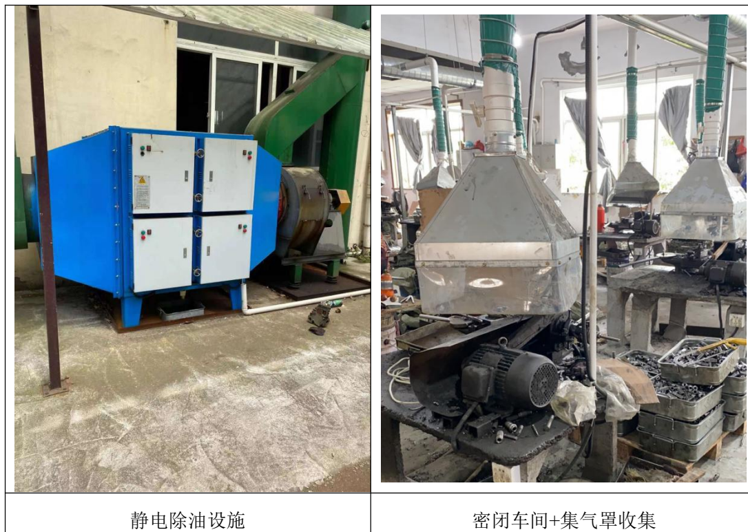
图 3-3 企业废气处理设施照片
